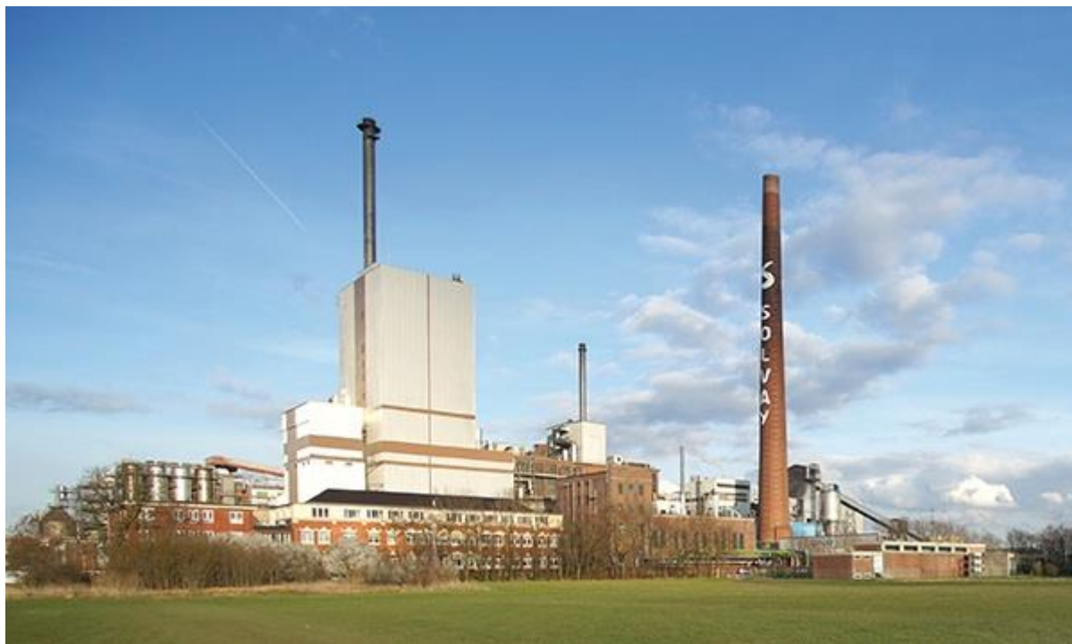
Solvay anlægget i Rheinberg, hvor der vil ske en større modernisering af energiforsyningen.
